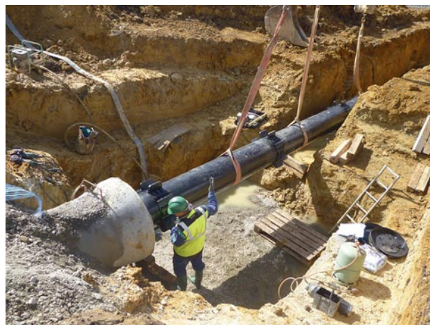
Remplacement d'un premier tronçon du feeder fonte D500 d'Angreviers à Gorges
