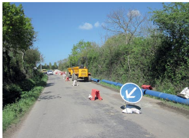
► Renforcements du réseau de transport (1 182 000 € HT) Pornic, liaison Nord Herberdière/refoulement Gâtineaux-La Plaine
